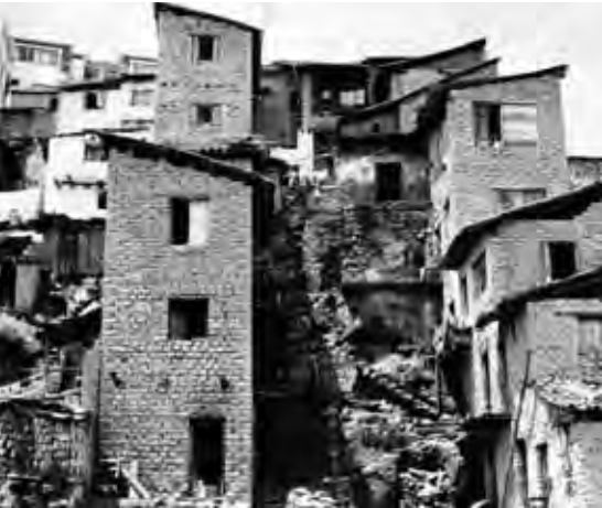
Viviendas construidas en el declive de la quebrada Marín, en el borde que da al barrio de La Tola (LM). Años 1970-1980.
