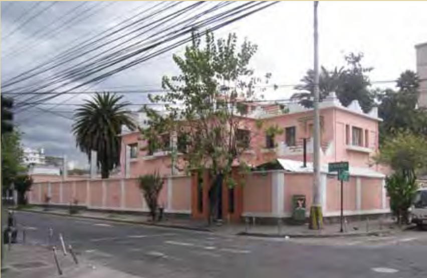
Edificación racionalista, ubicada en la esquina suroccidental de la intersección de las calles 9 de Octubre y general Francisco Robles (RAD). 2010.
