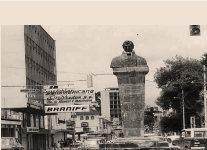
Avenida Amazonas y calle Jorge Washington (LM). Años 1970-1980.
