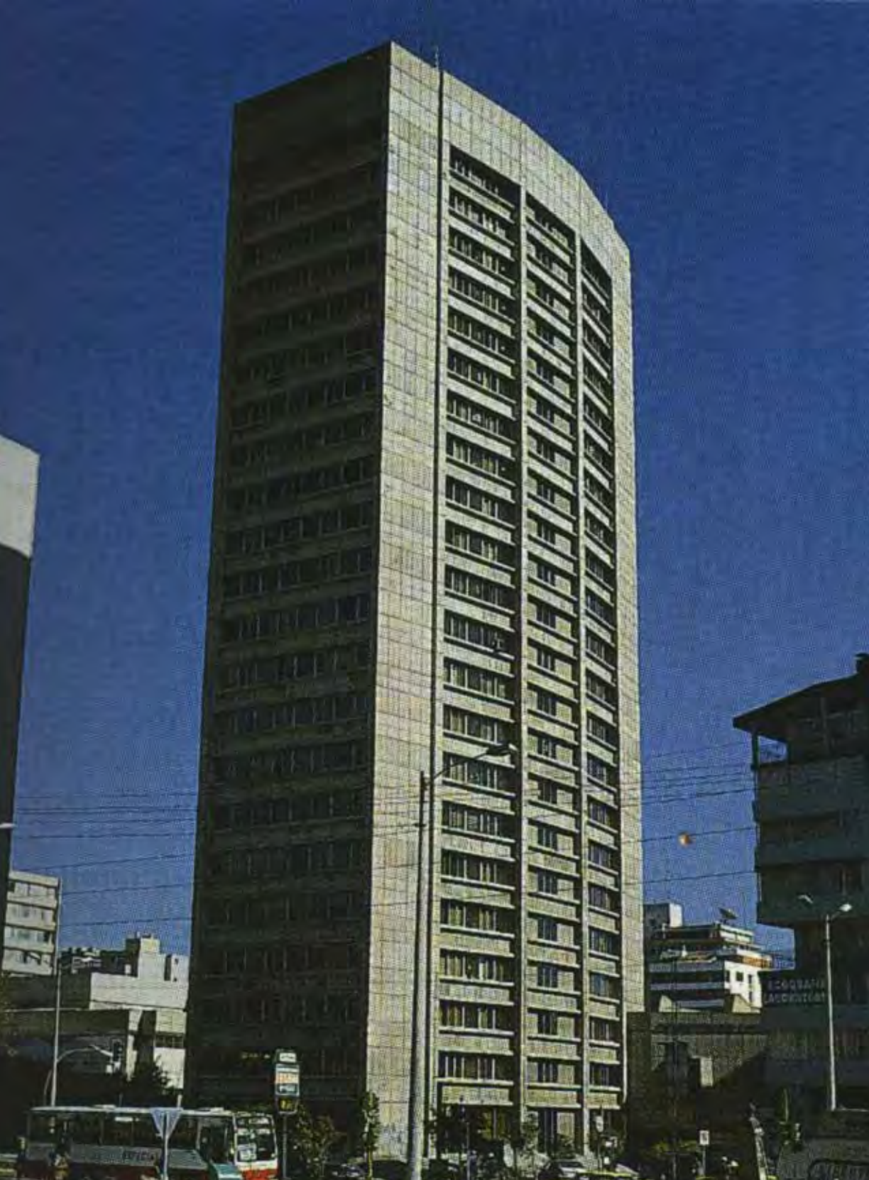
Edificio de la Corporación Financiera Nacional, diseñado en el año 1974 por los arquitectos Ovidio Wappenstein, Ramiro Jácome y César Gálvez, fue construido en 1978 por Semaica, Sevilla y Martínez, ingenieros. Se encuentra sobre la avenida Patria, entre las calles Juan León Mera, Reina Victoria y 18 de Septiembre. Tomada de la "Guía de Arquitectura de la ciudad de Quito", Junta de Andalucía, Consejería de Obras Públicas y Urbanismo, Dirección de Arquitectura y Vivienda, Sevilla-Quito, 2004.
