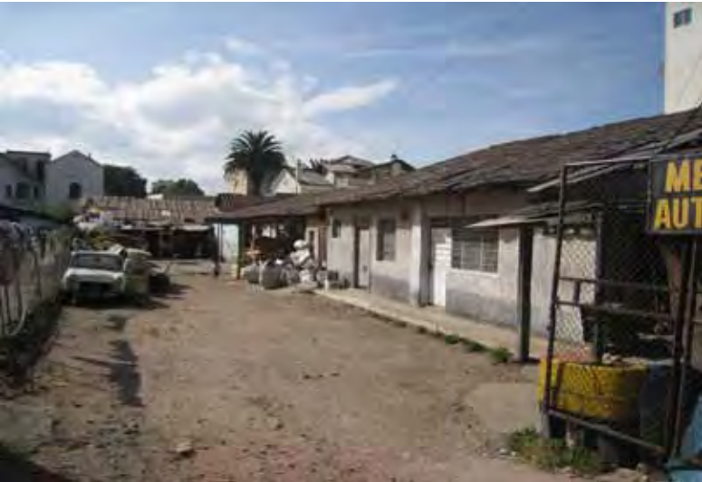
El deterioro de algunas edificaciones de La Mariscal es evidente y un problema persistente. La utilización de las viviendas con usos no adecuados a sus estructuras físicas y funcionales, dan lugar a procesos acelerados de deterioro. Calle Ulpiano Páez, entre Veintimilla y Cordero (RAD). 2010.
