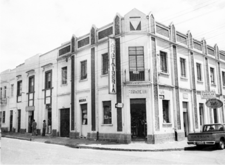
Casas adosadas de dos plantas y sobre línea de fábrica, construidas por la Caja de Pensiones en la calle Juan León Mera y Joaquín Pinto. El sector urbano donde se ubican estas edificaciones, son las menos alteradas por la renovación urbana y edilicia, ocurrida con la incorporación de edificaciones en altura y con tecnologías modernas (MS). Años 1980-1990.
