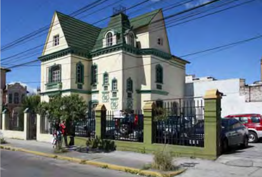
Puertas, ventanas, cercha de la estructura de cubierta y herrajes de los cerramientos, de alto valor estético y de diseño, han sido sustituidas en una reciente intervención. (RAD) 2010
