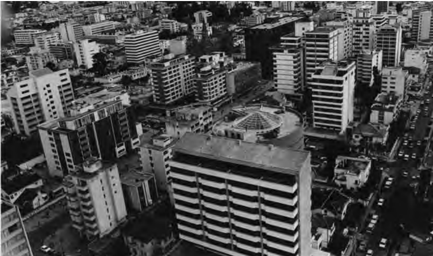
Vista aérea del sector de la avenida Amazonas y Washington en La Mariscal. En primer plano el edificio de la Mutualista Pichincha, atrás el Centro Comercial Espiral y al fondo la iglesia de Santa Teresita. La construcción en altura gana fuerza en los años 1970, especialmente sobre el eje vial de la Amazonas, proceso que en la actualidad prácticamente se ha detenido (LM). Años 1970-1980.
