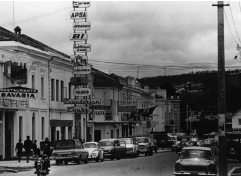
Eje vial de la avenida Río Amazonas, “zona rosa” de la ciudad. El comercio transformó la funcionalidad de las edificaciones en planta baja, y la homogeneidad constructiva, volumétrica y estética, se alteró por esta actividad (LM). Años 1970-1980.
