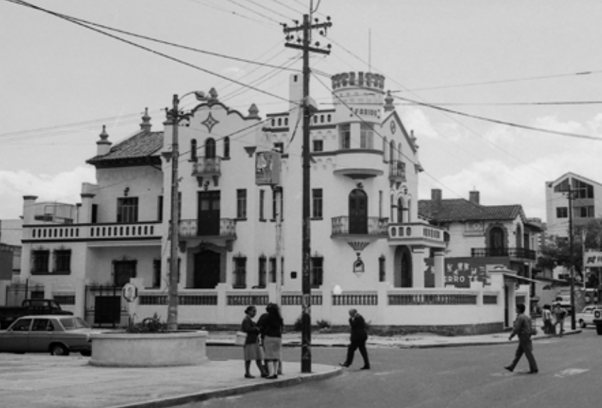
Sobre la avenida 6 de Diciembre y Baquedano, se levanta un voluminoso castillo, tomando con menos éxito los elementos que con soltura realizó Rubén Vinci (MS). Años 1980-1990.
