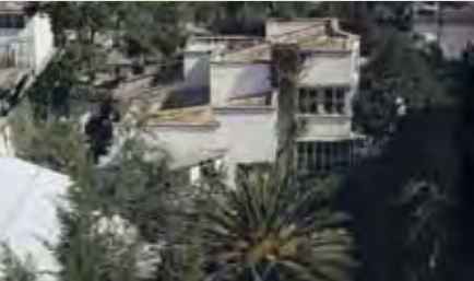
Residencia del arquitecto Carlos Kohn, diseñada y construida por él en el año 1950, ubicada en la avenida 12 de Octubre y Lizardo García. Tomada de la “Guía de Arquitectura de la ciudad de Quito”, Junta de Andalucía, Consejería de Obras Públicas y Urbanismo, Dirección de Arquitectura y Vivienda, Sevilla-Quito, 2004.
