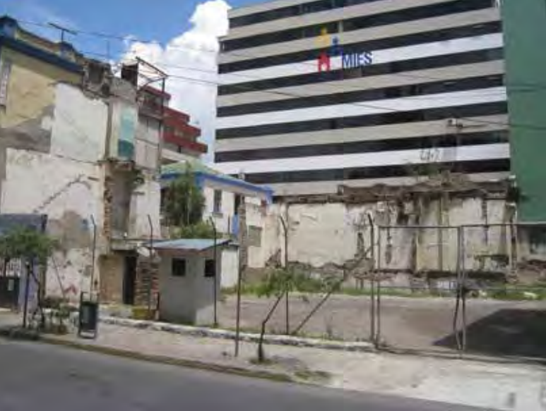
Calles 9 de Octubre y Robles. El interés sobre los terrenos, no se comparece con el daño que se produce. A la afectación estructural que se causa a las casas vecinas, se suma el deterioro al paisaje urbano inmediato. (RAD) 2010.
