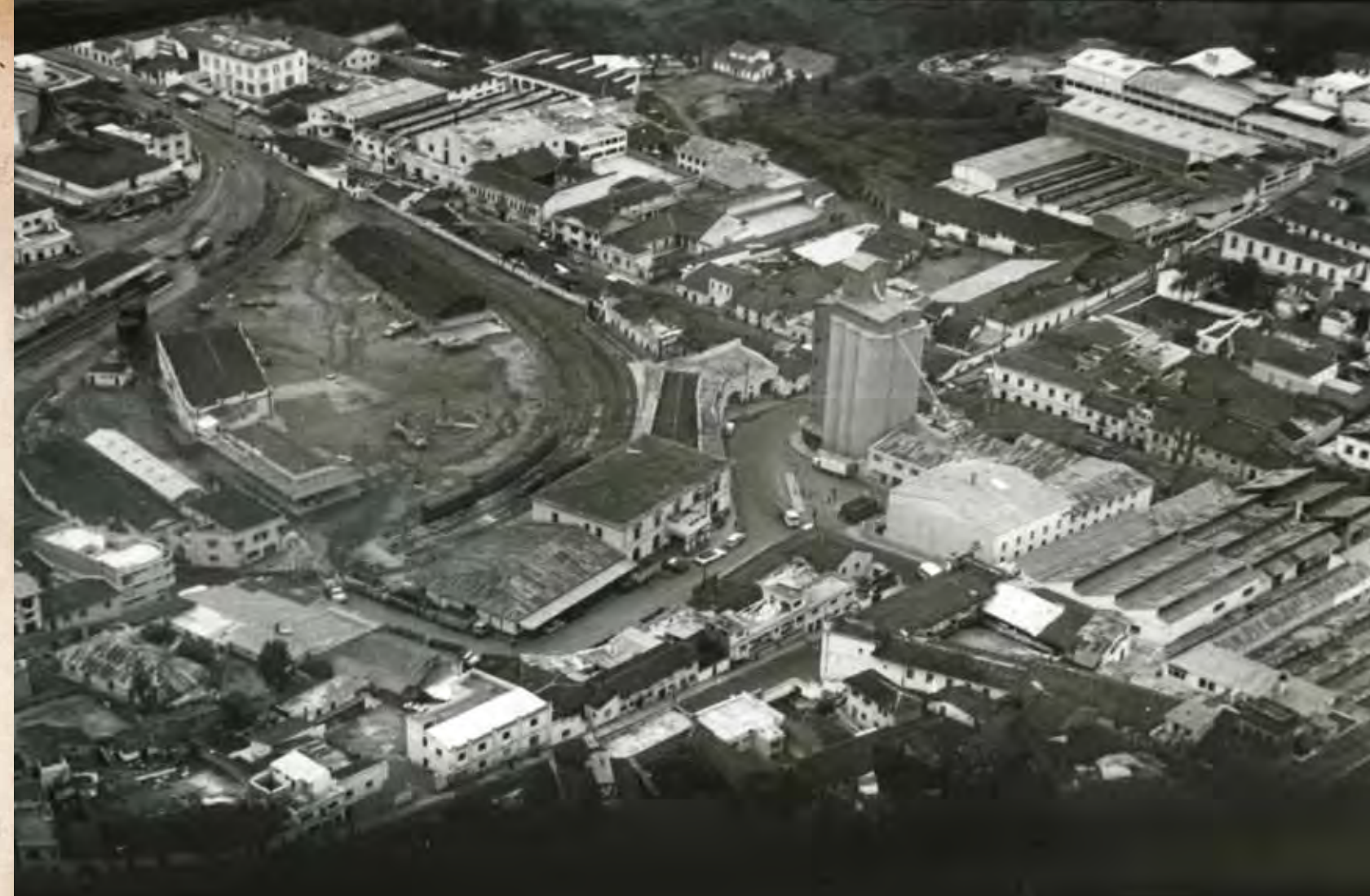
Estación del ferrocarril en Chimbacalle, al sur, puerta de entrada de la modernidad a la ciudad. Por ella ingresaron nuevas técnicas y materiales de construcción -hierro y cemento-, incorporándose con mayor rapidez nuevos estilos arquitectónicos. Se facilitó el consumo de productos del mar, ampliándose la dieta, y la migración de campesinos a la ciudad (LM). 1975.
