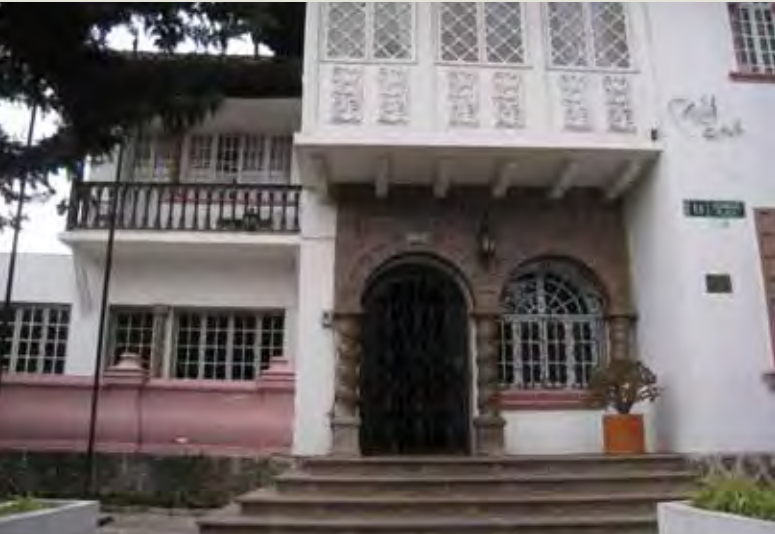
Casa sobre la calle Leonidas Plaza y 18 de septiembre. Destaca el trabajo artesanal del moldeado y coloración de la portada del acceso principal, con morteros de arena – cemento y pigmentos, para asemejar piedra en las columnas salomónicas que sostienen la arquería y el trabajo prodigioso de la carpintería del volumen superior. (RAD) 2010
